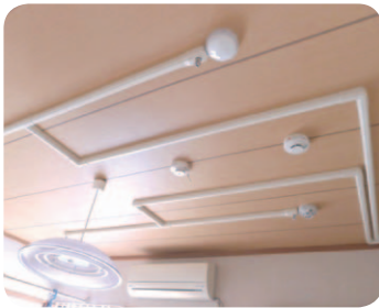
写真はわくわくホーム
